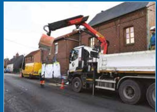
Compétence de Dieppe-Maritime, les branchements d'eaux vétustes en plomb sont remplacés au fur et à mesure. Une gêne incontournable pour la circulation en centre bourg.
